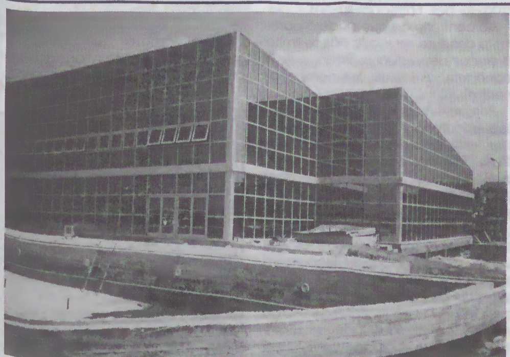
Um aspecto das Piscinas em fase de conclusão na beira-rio, empreendimento de vulto a inaugurar muito em breve.
