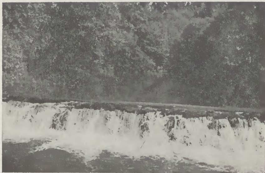
Durrães — Açude do Rio, a jusante da Ilha dos Amores
