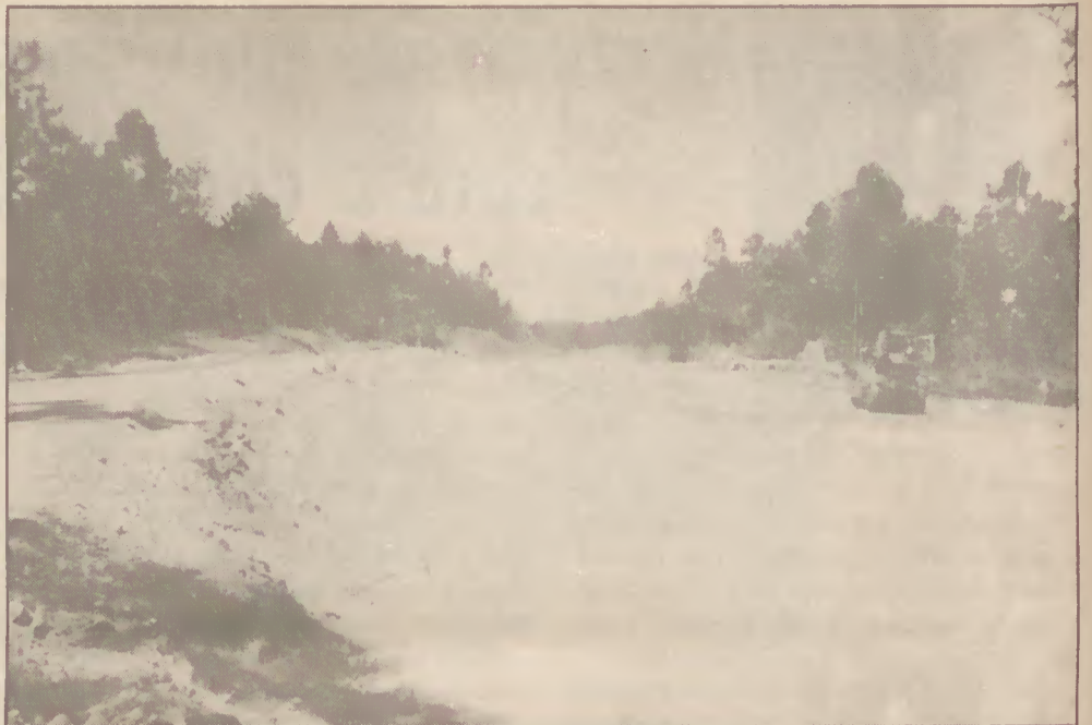
ICI em Marinhãs - Obras de terraplanagem do Cávado ao Neiva
