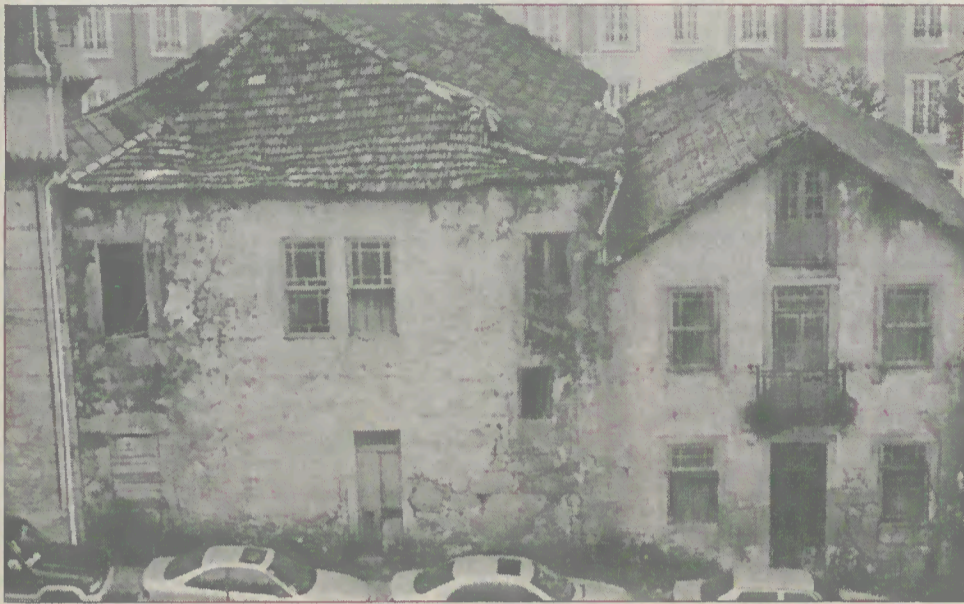
O edifício da antiga Loja Espanhola com o telhado parcialmente destruído
