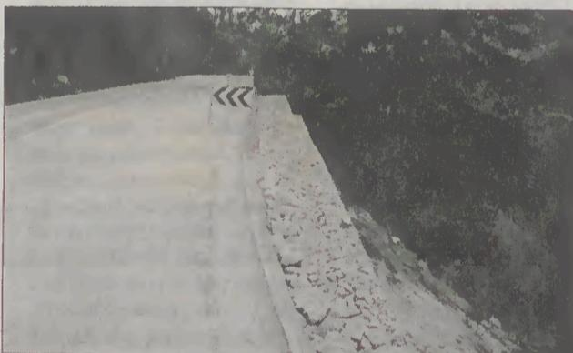
Os temporais inusitados que, em Março de 2001, se fizeram sentir com grande intensidade na nossa região, destruíram parcialmente a berma da EN 308, que liga a Vila do Gerês a Leonte, com a queda de um enorme talude um pouco acima do Vidoeiro. Por via disso, o tráfego fez-se naquela zona e durante mais de dois anos, apenas numa só facha de rodagem, com todos os problemas daí resul-
