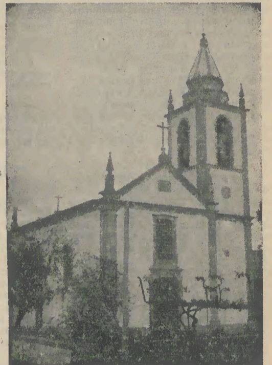
Igreja Paroquial de S. Vicente de Ponte
