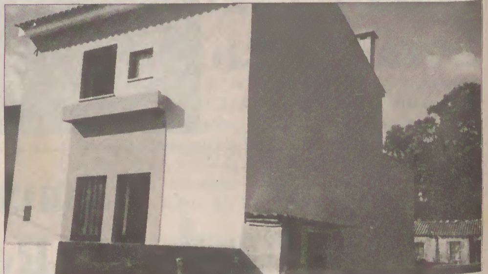
Apúlia depois da intervenção
