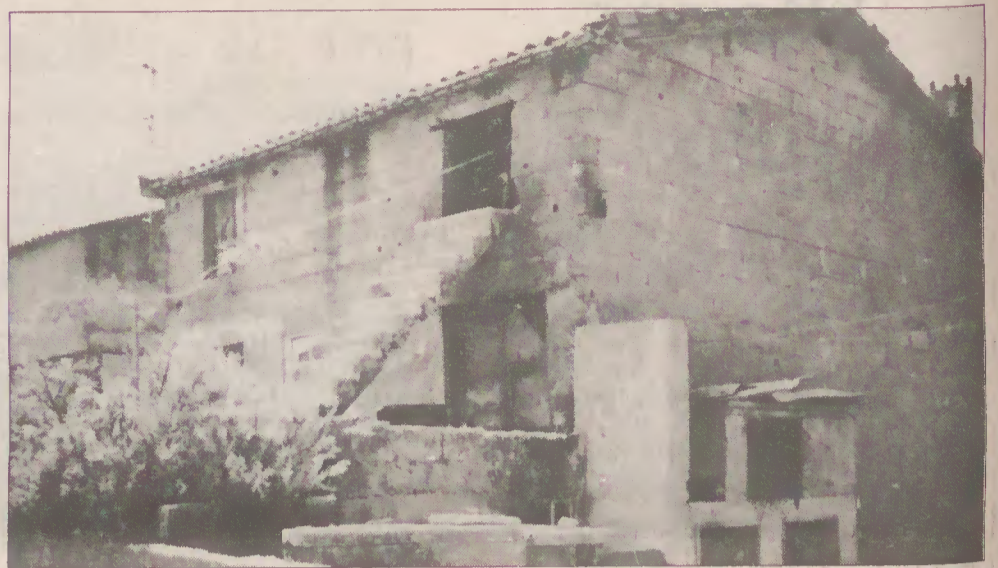
Apúlia antes da intervenção
