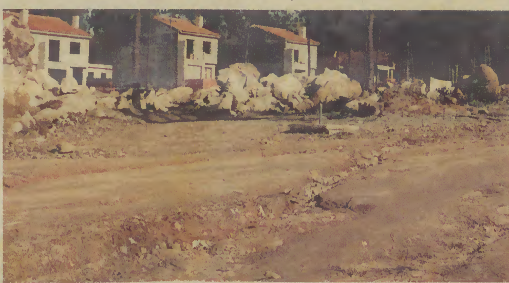
Estado calamitoso em que se encontra o loteamento da Habitação Social de Goios
