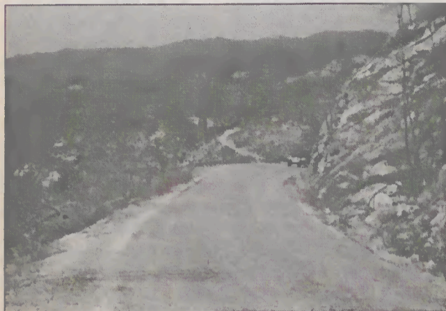
A estrada da Ermida não dispõe de qualquer protecção. Até quando?
