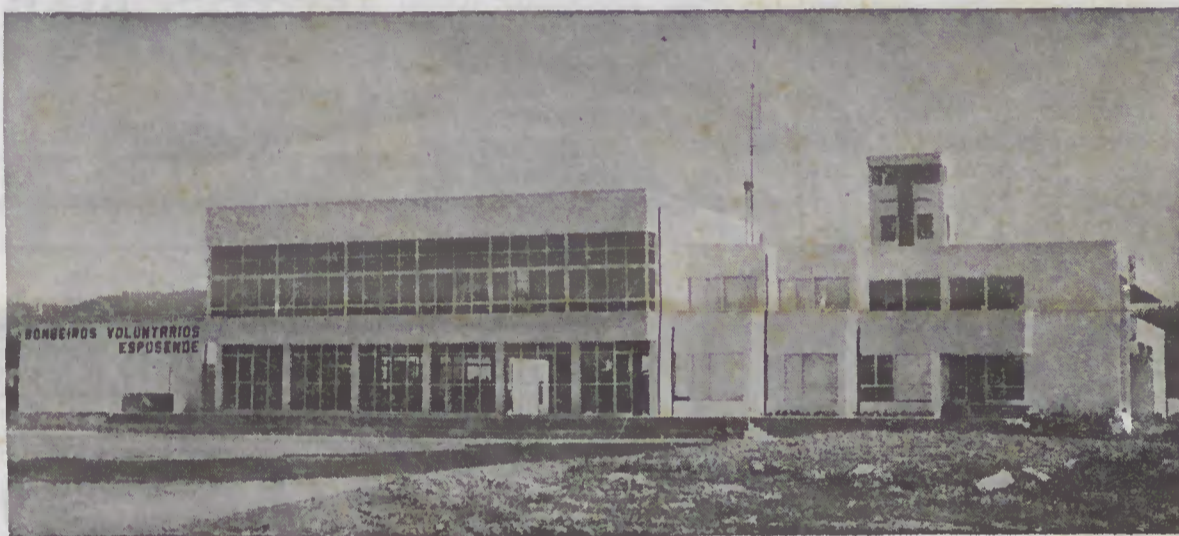
Quartel-Sede dos Bombeiros Voluntários de Espoense
