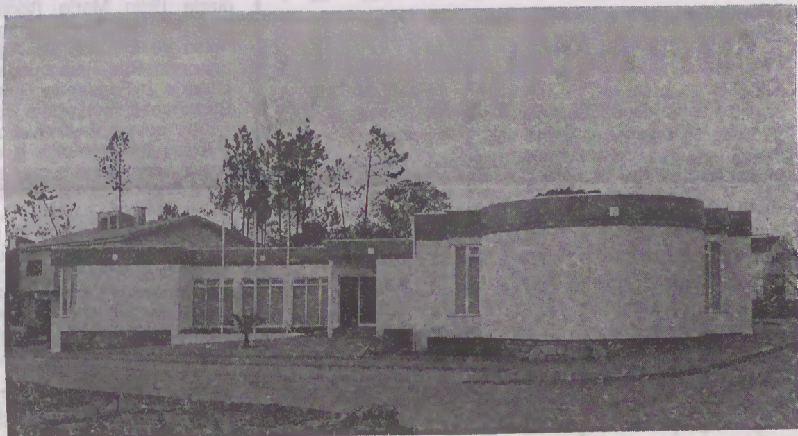
Sede da Junta de Freguesia de Palmeira de Faro
