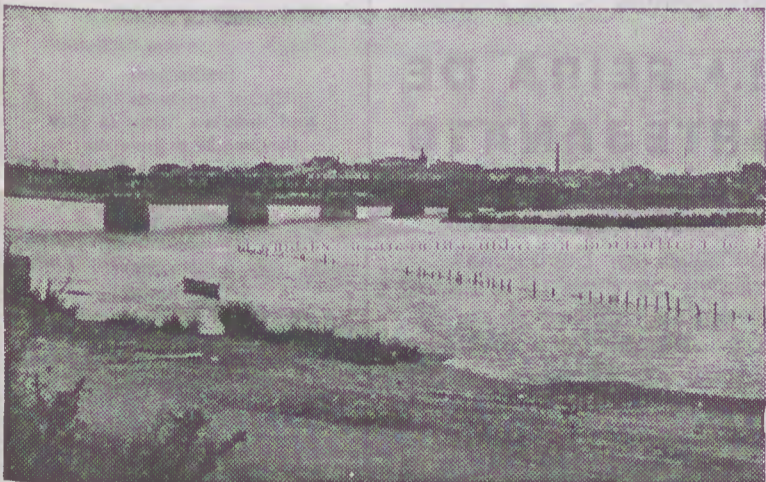
A estacada colocada junto à Ponte de Fão
