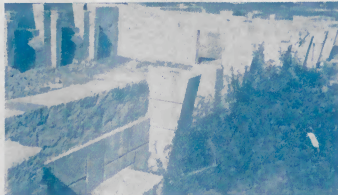
Igreja nova de Prado em construção
