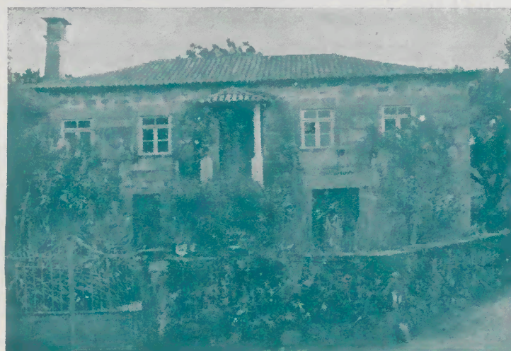
Residência paroquial de Vila Verde
