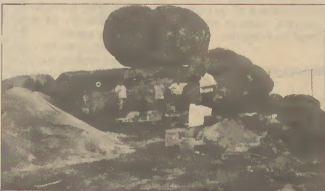
Local onde foi implantada a construção, na altura do início das obras
