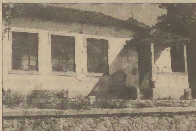
Escola velha, actual sede da Junta e Associação Cultural de Dornelas, onde se estão a fazer obras de restauro e ampliação
