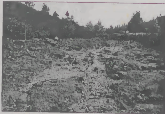
Fig. n.º 4: A degradada Estrada da Jeira
