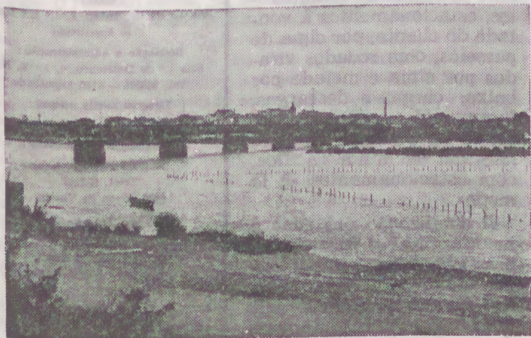
A estacada colocada junto à Ponte de Fão — Foto de: M. M. M. Costa
