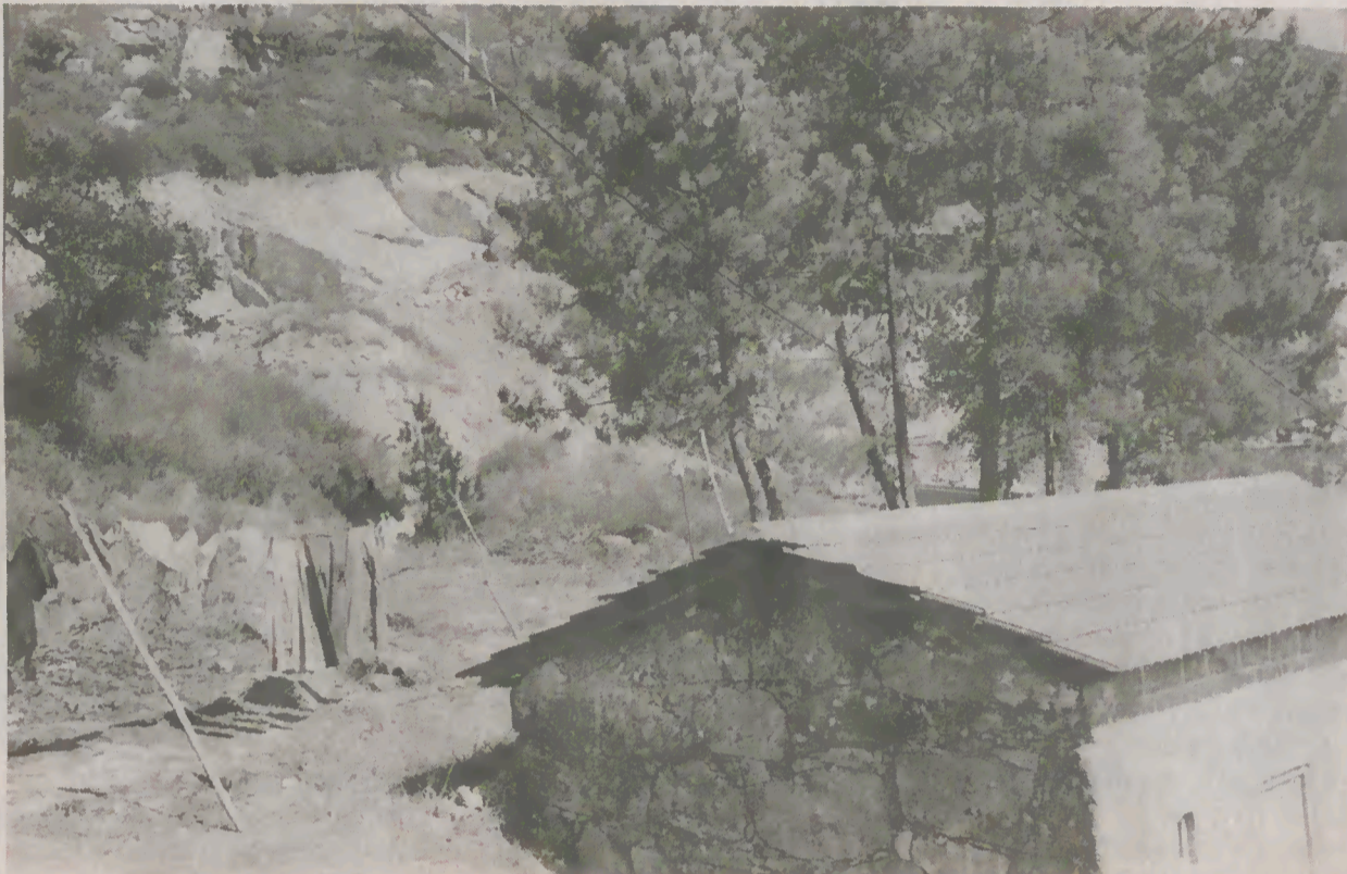
As casas estão ali bem ao lado da pedreira e os telhados tiveram que ser renovados.
