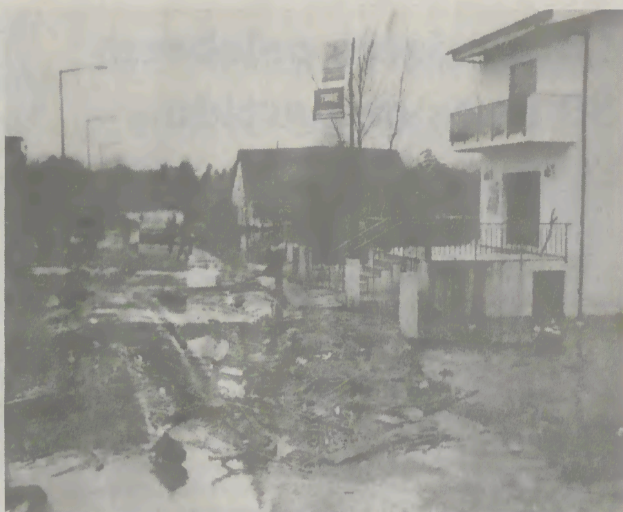
O caos instalou-se na quinta da Botica, na Vila de Prado.
