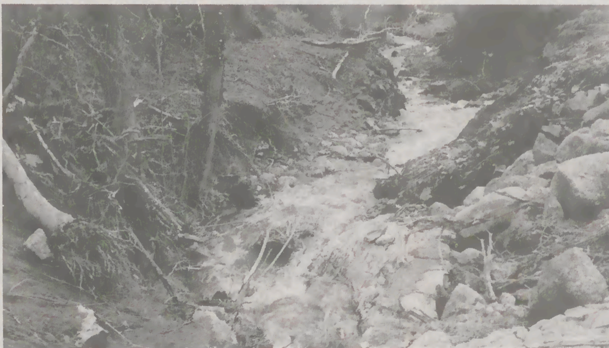
Pedregulhos e árvores arrancadas pela raiz rebolaram encosta abaixo.
