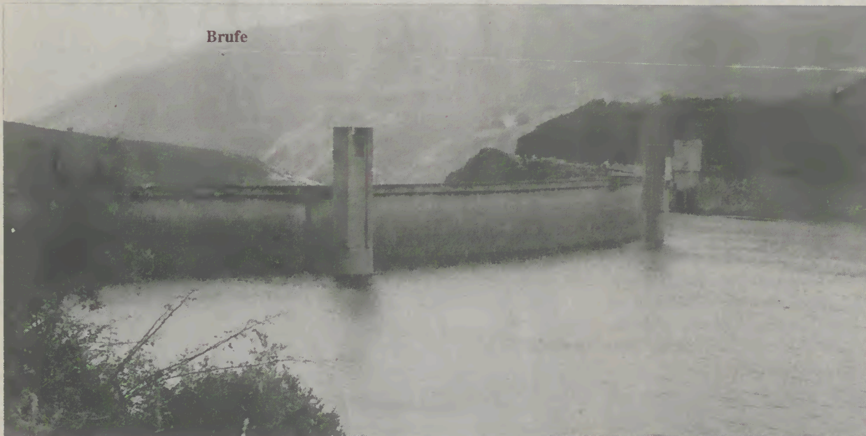
Barragem de Vilarinho, vislumbrando-se ao alto a nova estrada montanhosa que lhe dá acesso desde Brufe.
