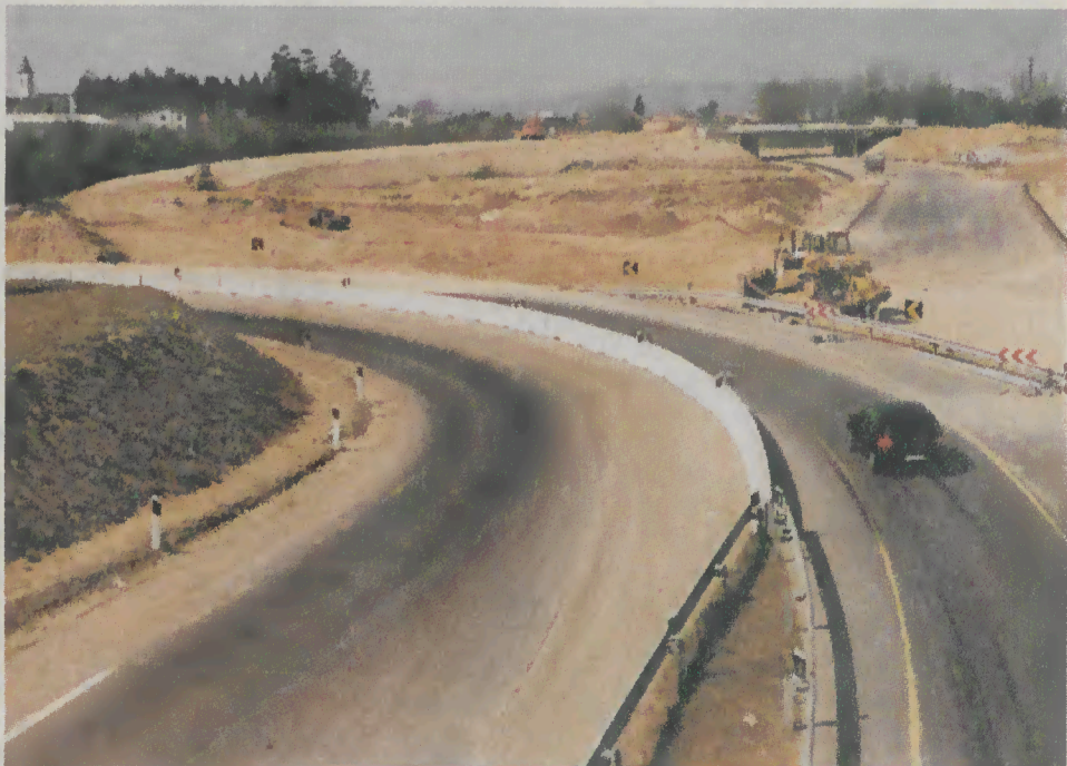
Zona do nó de bifurcação da variante, para ligação à EENN 201 e 101, ainda ocupada com o acesso provisório à EN 205, que irá desaparecer.
