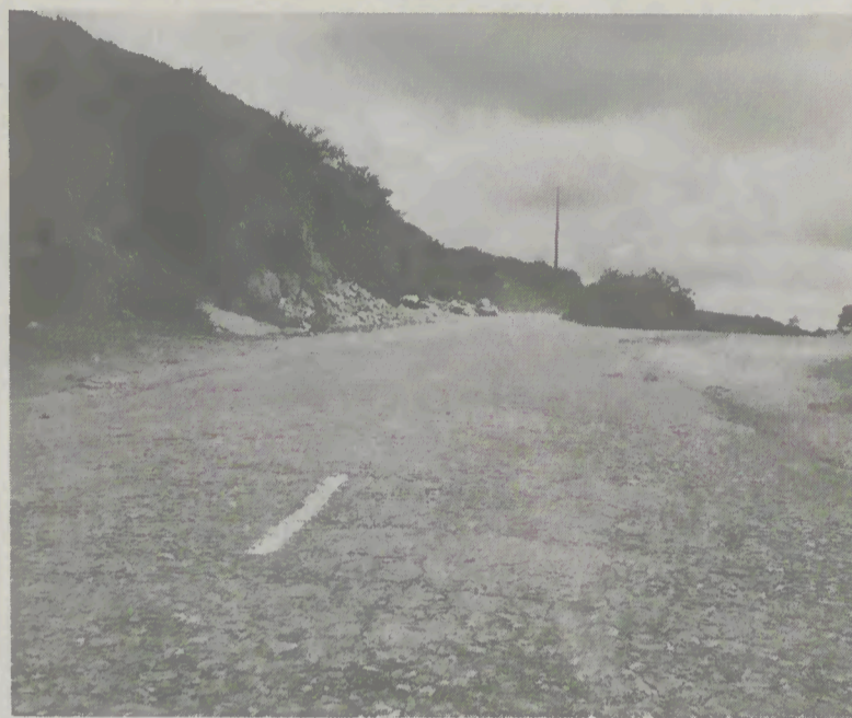
A Câmara está decidida a completar a inacabada ex-Estrada Nacional 307 (Ponte de Lima - Terras de Bouro), interrompida precisamente neste local (Boalhosa).
