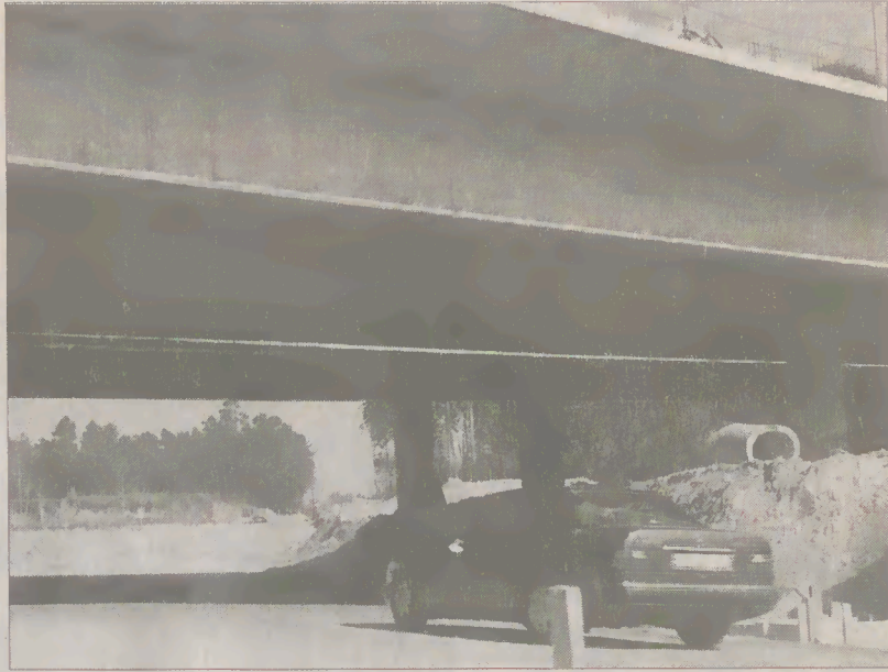
Os dois tabuleiros já cobrem a rebaixada estrada marginal.
