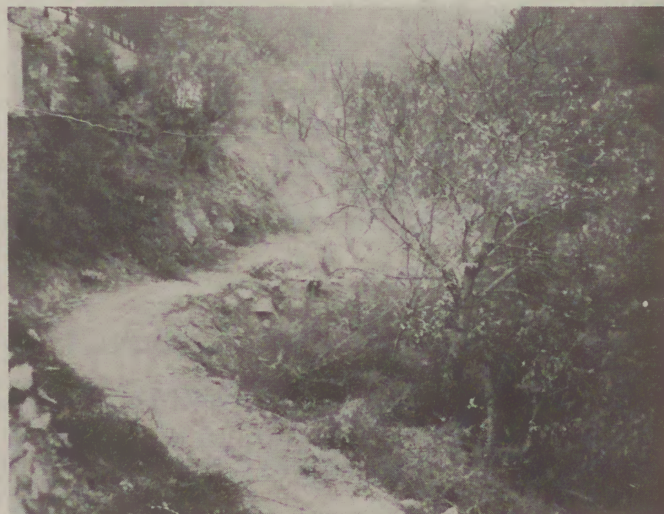
Aspecto das obras do desvio da estrada
