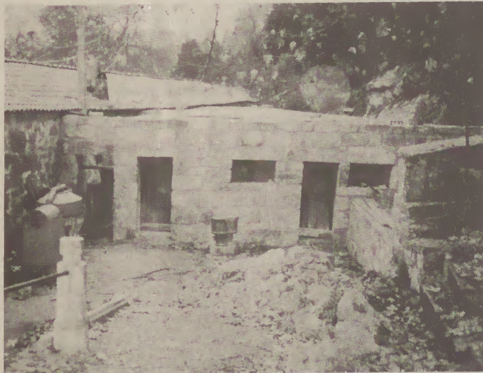
Obras em curso dos sanitários atrás dos Quartéis
