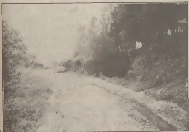
Aspecto das obras de abertura da nova estrada da Abadia
