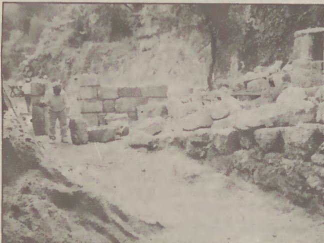
Início das Obras dos novos sanitários e balneários na Abadia
