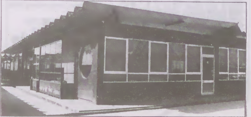
Novo Edifício do 1º Ciclo do Ensino Básico
