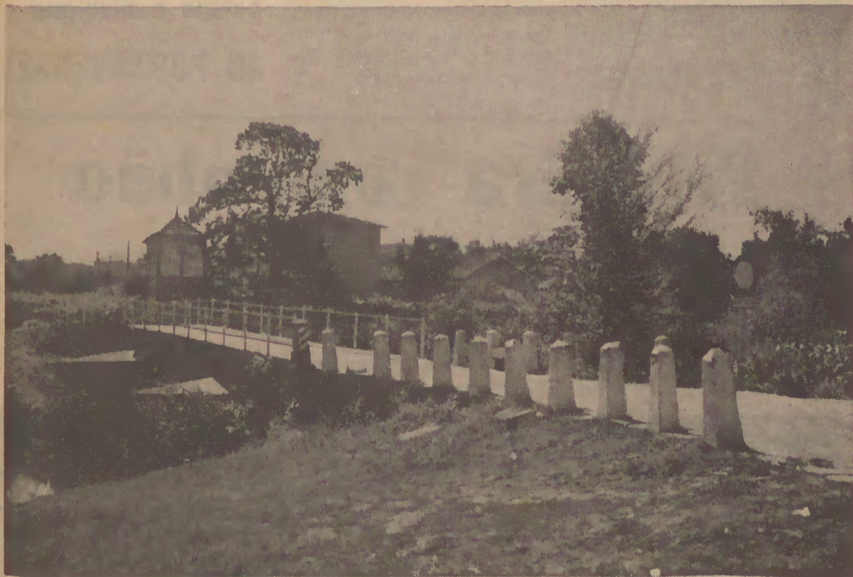
Em Fragoso, os pesados não passam na ponte Espregueira
