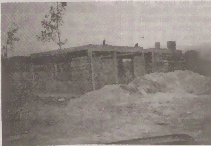
Construção do edificio do Jardim de Infância.
