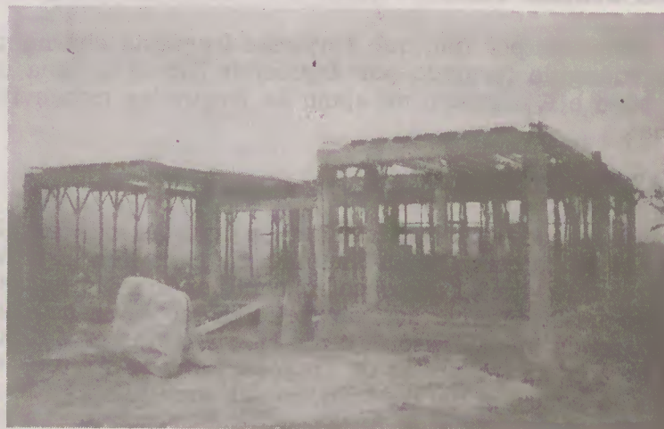
Sede da ACARF, em construção desde Maio do corrente ano.
