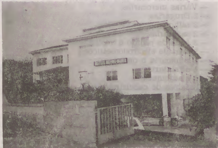
Instituto Materno-Infantil em fase de acabamento das obras de ampliação.
