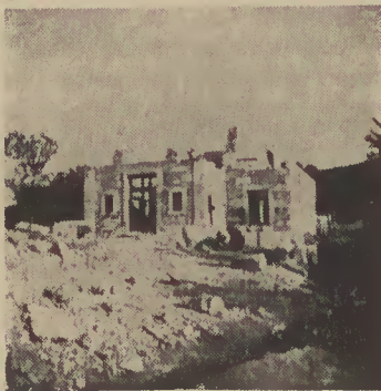
Vila Verde — Pedregais — Mosteiro dedicado a S. Bento (Em construção)
