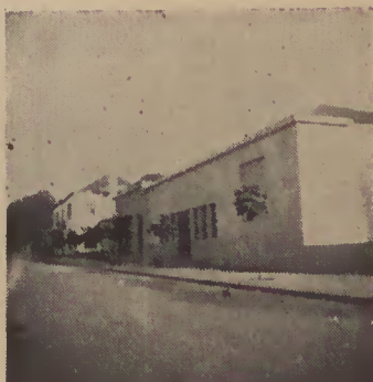
Vila Verde —Nova sede da Banda de Vila Verde (em construção)
