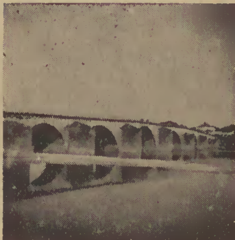
Vila Verde — Prado — Ponte sobre o Cávado (Monumento Nacional)
