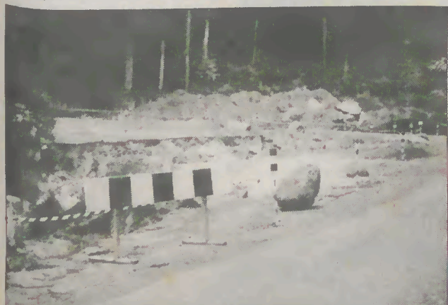
Uma quebrada de água destruiu a estrada Covas - Covide
