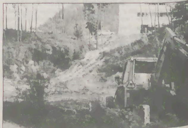
Um aspecto das obras de terraplanagem
