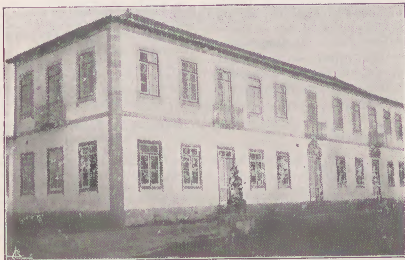
Barcellos — Caldas de Elrôgo — Edifício do Hotel
