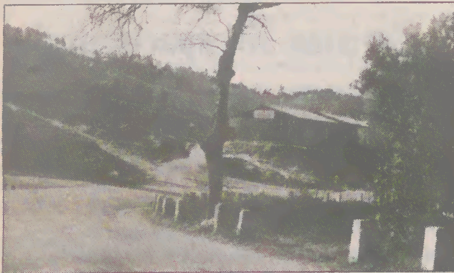
Início das obras da estrada da Serra do Carvalho
