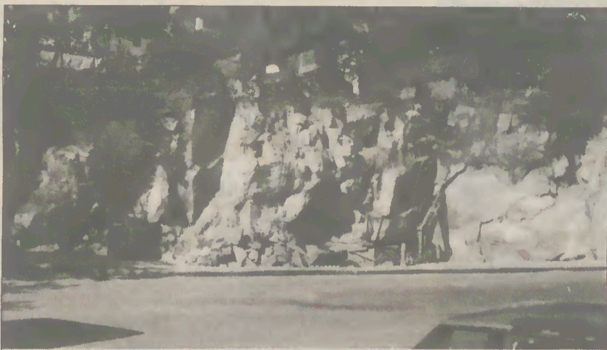
As escavações para o edifício de Via Cova já começaram...
