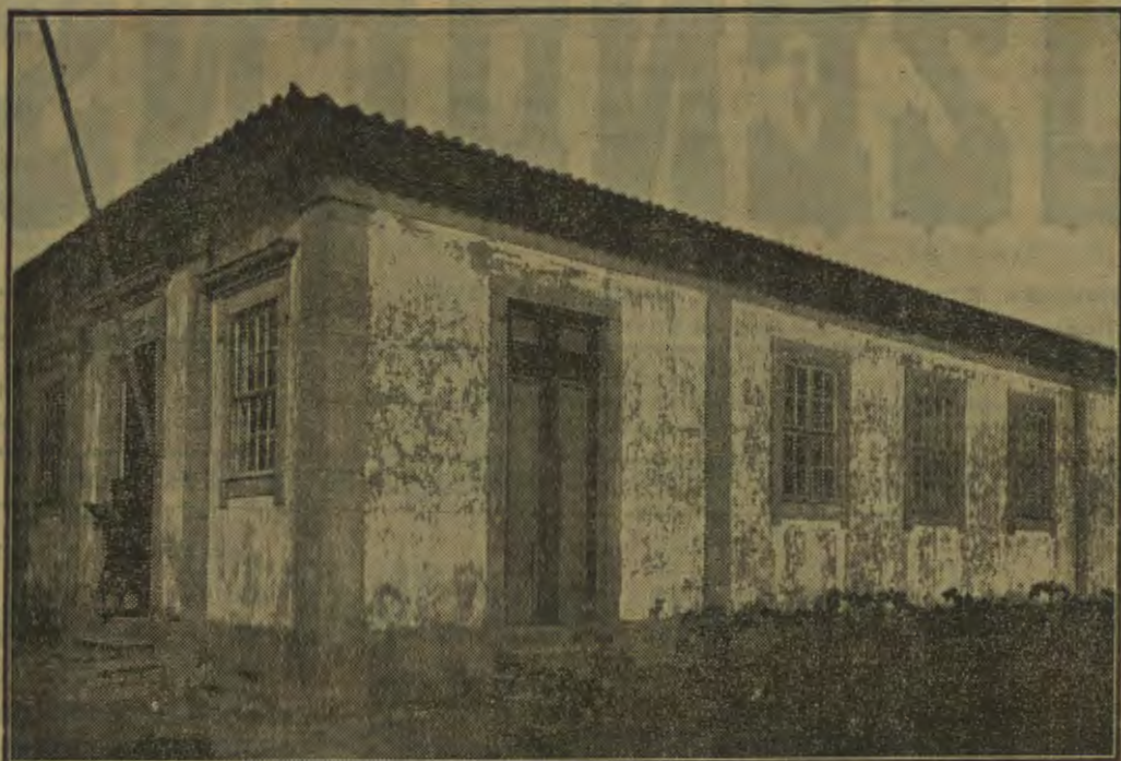
Edifício da antiga Escola Conde de Ferreira
