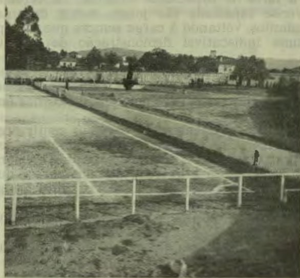
Um sugestivo aspecto das obras realizadas no Campo «Horácio de Queirós»: à esquerda, vista parcial do rectângulo de futebol; ao centro, o muro suporte do lado sul com as instalações para os suplentes; indicado pela seta, o campo pequeno (ringue); mais acima, à direita, o bar e os balneários.
