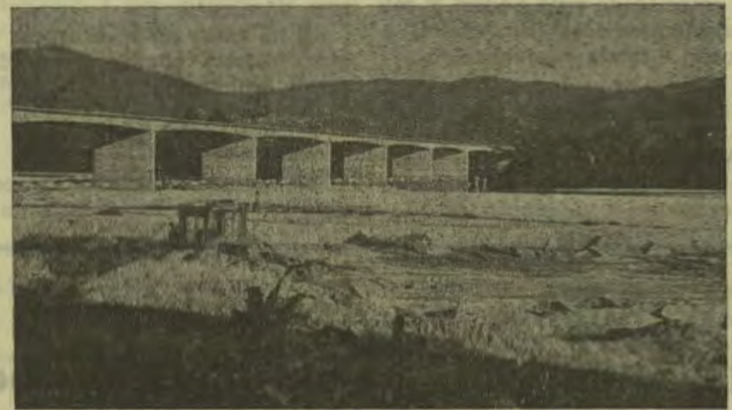
Um aspecto da ponte sobre o rio Lima, em Lanheses
