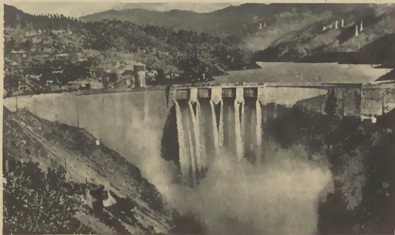
Aproveitamento hidroeléctrico da Caniçada
