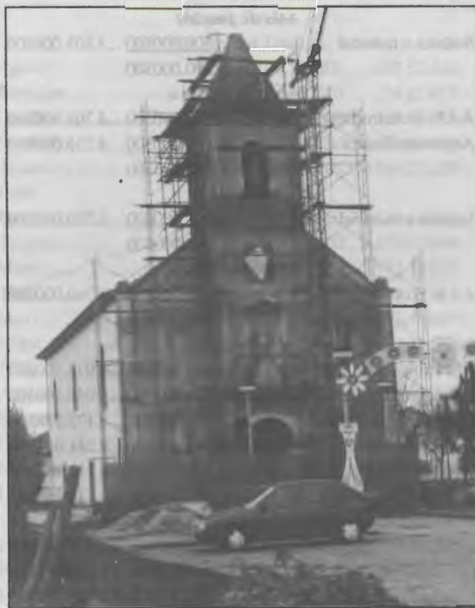
Um aspecto das obras da Torre da Igreja Paroquial
