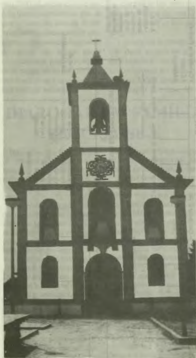
Fachada existente da Igreja Paroquial
