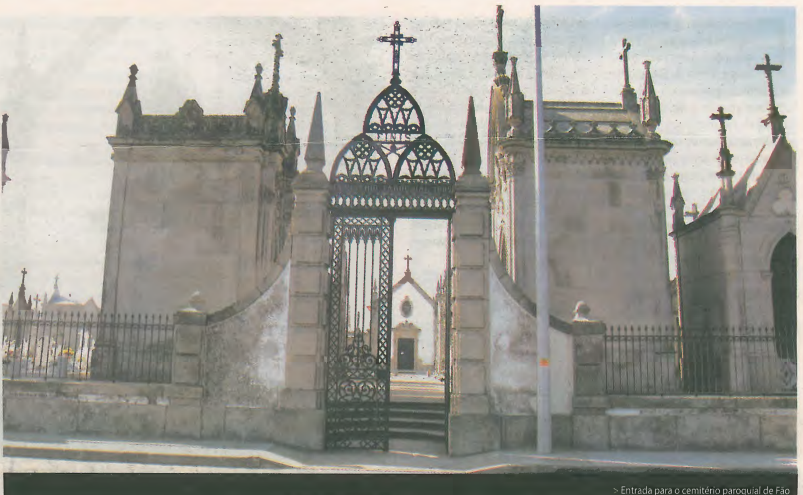
> Entrada para o cemitério paroquial de Fão
