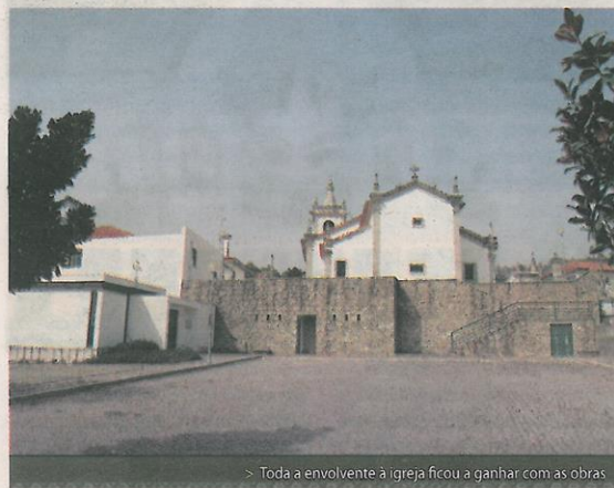
> Toda a envolvente à igreja ficou a ganhar com as obras
