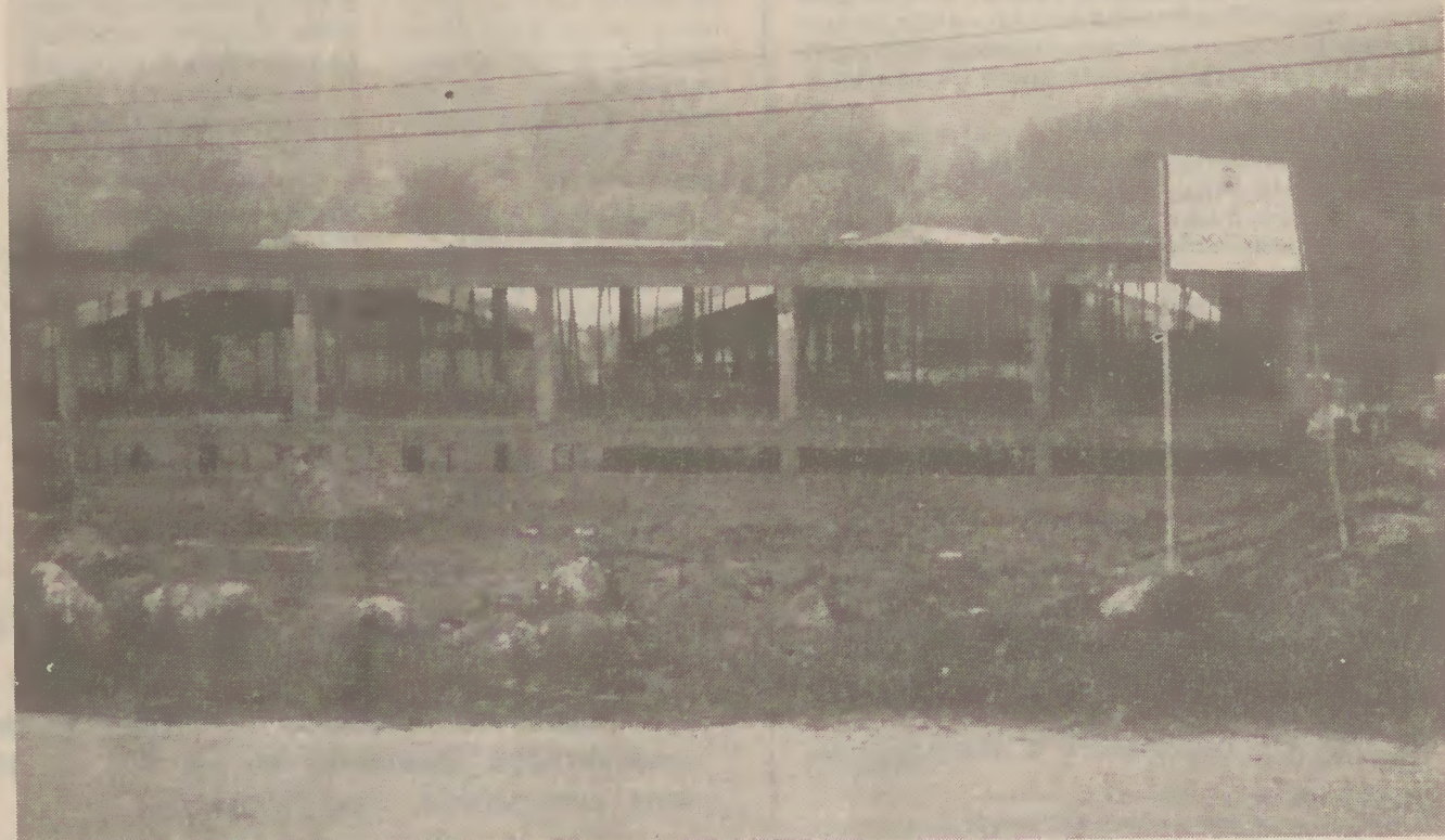
Fábrica de cerâmica em construção no loteamento industrial de Terras de Bouro (no Vau - Balança)
