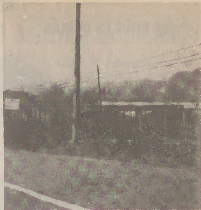
A nova unidade de cerâmica em Vau, ainda em construção
