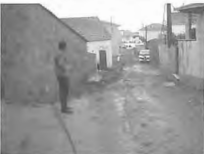
A Rua da Cangosta Nova durante a fase das obras. À esquerda vê-se o alargamento do Sr. Manuel Capitão
