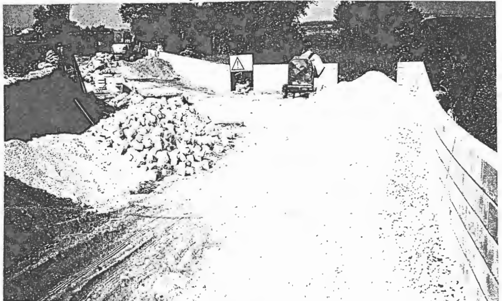
Fase da obra do arranjo da Fonte, no Lugar de Baixo. (Foto: M. Azevedo)
