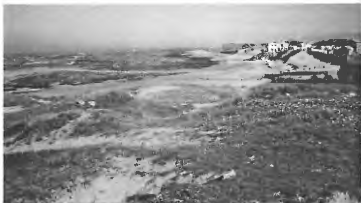
Figura 1: Praia de Mar, Junho de 2003. A norte da zona do galgamento (assinalada pela seta) observam-se os sacos, com areia e seixos, colocados na base da arriba (em Fevereiro de 2003) e um pequeno enrocamento, feito com blocos de granito.
