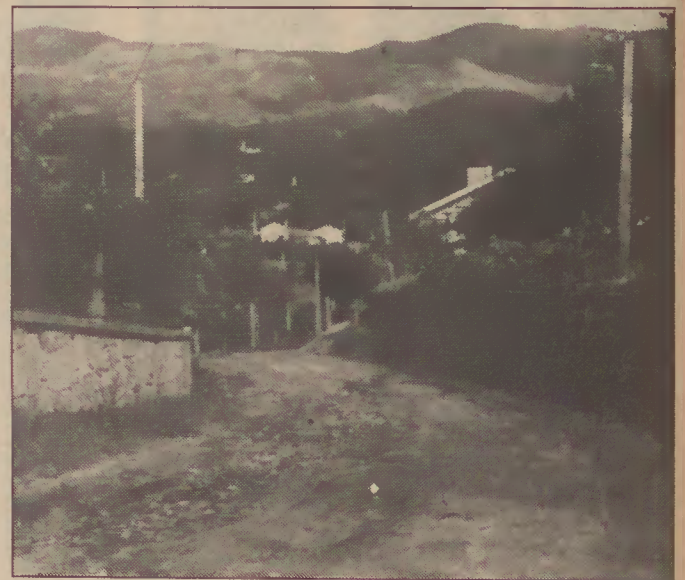
Recomeçaram as obras no troço de estrada de S. Veríssimo à Encruzilhada. Será que agora vai?
