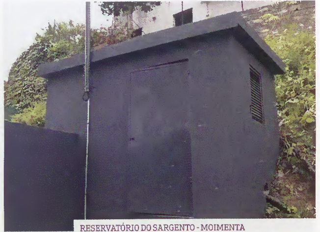
RESERVATÓRIO DO SARGENTO - MOIMENTA
