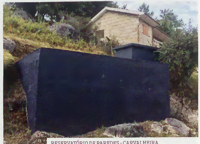
RESERVATÓRIO DE PAREDES - CARVALHEIRA
