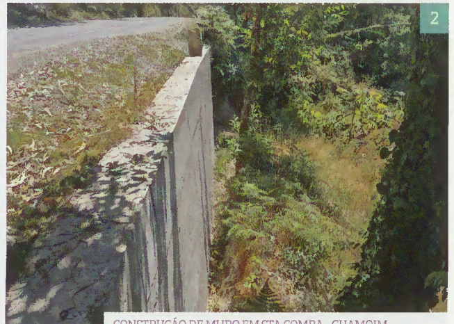
CONSTRUÇÃO DE MURO EM STA COMBA - CHAMOIM
