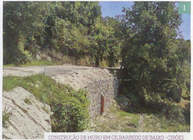
CONSTRUÇÃO DE MURO EM GILBARBEDO DE BAIXO - CIBÕES
