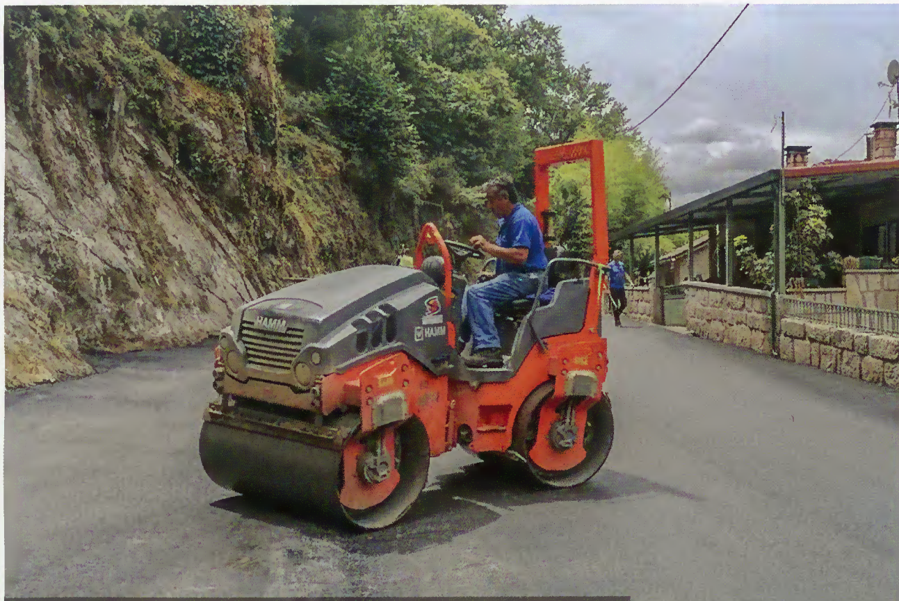
PAVIMENTAÇÃO EM GRADOURO E PERGOIM - CHAMOIM
