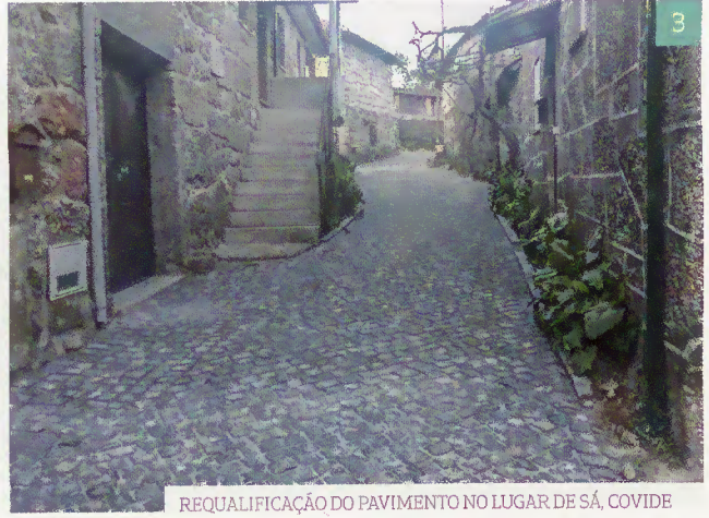
REQUALIFICAÇÃO DO PAVIMENTO NO LUGAR DE SÁ, COVIDE
