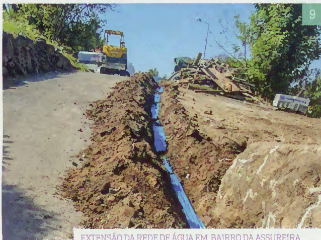
EXTENSÃO DA REDE DE ÁGUA EM BAIRRO DA ASSUREIRA
