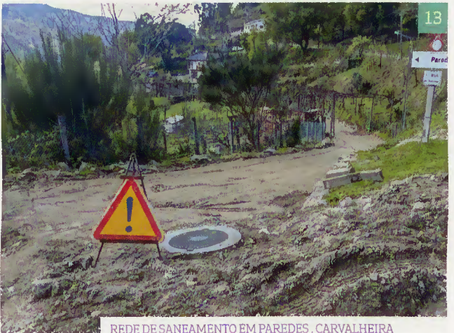
REDE DE SANEAMENTO EM PAREDES, CARVALHEIRA
