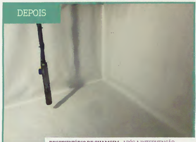
RESERVATÓRIO DE CHAMOIM - APÓS A INTERVENÇÃO
