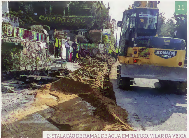
INSTALAÇÃO DE RAMAL DE ÁGUA EM BAIRRO, VILAR DA VEIGA
