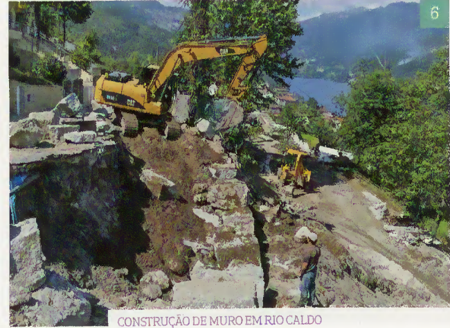
CONSTRUÇÃO DE MURO EM RIO CALDO
