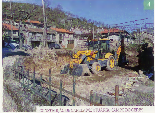
CONSTRUÇÃO DE CAPELA MORTUÁRIA, CAMPO DO GERÊS
