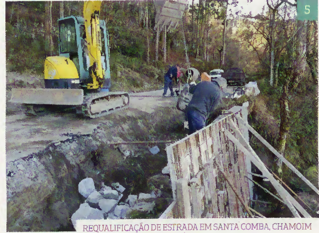
REQUALIFICAÇÃO DE ESTRADA EM SANTA COMBA, CHAMOIM
